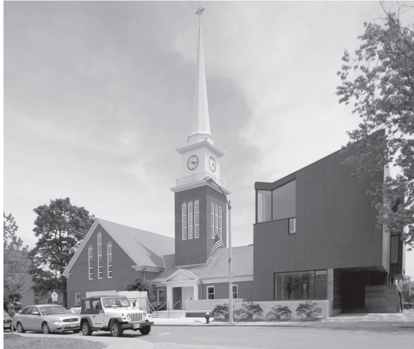
완공된 본당과 ECC 건물 외관(Holden St. 쪽) (2010)
